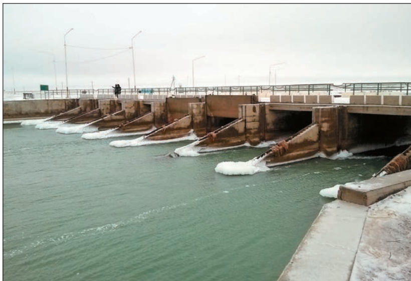
Водосбросное устройство Кокаральской плотины зимой. Идет сток воды из Малого Арала.
